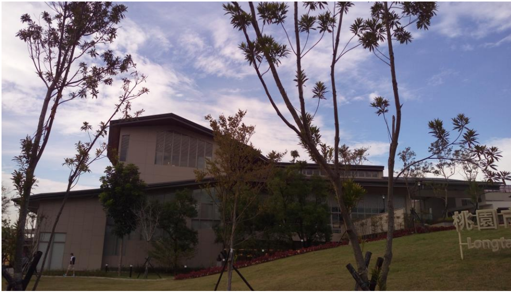
桃園市圖書館龍潭分館座落在一個小坂坡上
