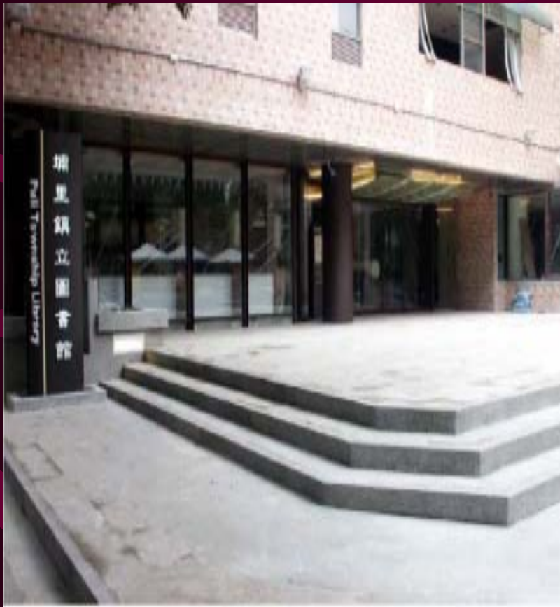
南投埔里鎮立圖書館改善後 一樓大門階梯
